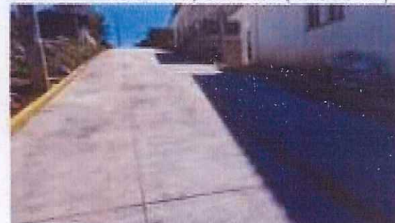
MEJORAMIENTO CAMINO RURAL PARAJE SAN JOSE ALDEA CHIMENTE, TOTONICAPAN, TOTONICAPAN. (100% AVANCE)
