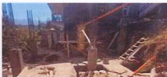
CONSTRUCCION EDIFICIO SANTUARIO DE LA CRUZ CANTON CHUICRUZ TOTONICAPAN, TOTONICAPAN (AVANCE 15.00%)
