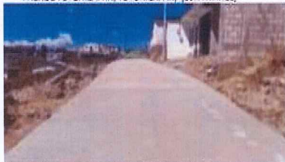
MEJORAMIENTO CAMINO RURAL SECTOR IGLESIA No. 1 PARAIE PAJUMUJUYUP CANTON CHIUSUC TOTONICAPAN. (95% AVANCE)
