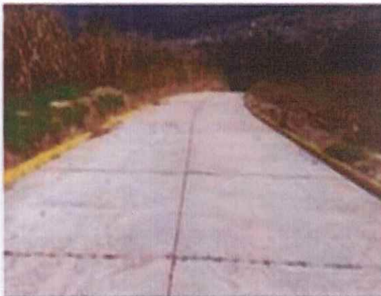
MEJORAMIENTO CAMINO RURAL PARAJE PAROXOX CANTON XESACMALIA, TOTONICAPAN, TOTONICAPAN (95% AVANCE)
