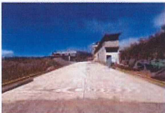
MEJORAMIENTO CAMINO RURAL TZAMSIGUAN PARAJE PAMESEBAL CANTON RANCHO DE TEJA TOTONICAPAN (100% AVANCE)
