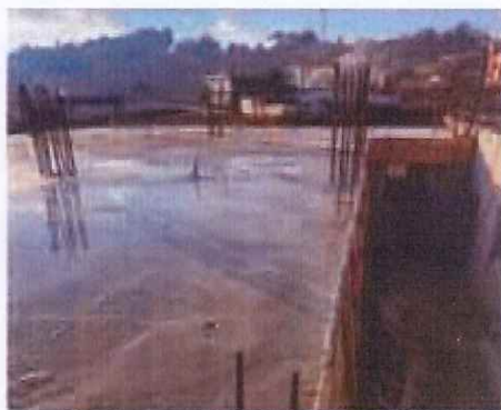
CONSTRUCCION PUESTO DE SALUD CANTON CHIXTOXA TOTONICAPAN, TOTONICAPAN. (70.00% AVANCE)
