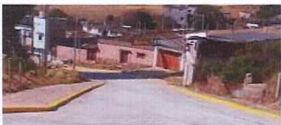
MEJORAMIENTO CAMINO RURAL CHISIGUAN XESACMAJA, CHITUMAX NIMAPA, POZO CHUICRUZ, XOLPEQUELLA CHUIXCHIMAL CENTRO TRES CORONAS TOTONICAPAN, TOTONICAPAN (35.00% AVANCE)
