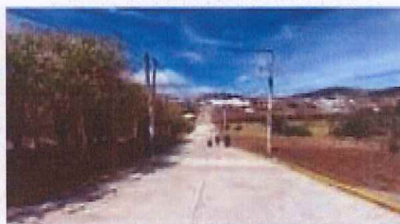
MEJORAMIENTO CAMINO RURAL CALLE CAXAJ ALDEA PAXTOCHA TOTONICAPAN, TOTONICAPAN. (100% AVANCE)
