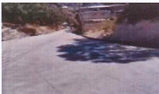
MEJORAMIENTO CAMINO RURAL VARIAS COMUNIDADES DEL MUNICIPIO DE TOTONICAPAN, TOTONICAPAN AVANCE FISICO 32%
