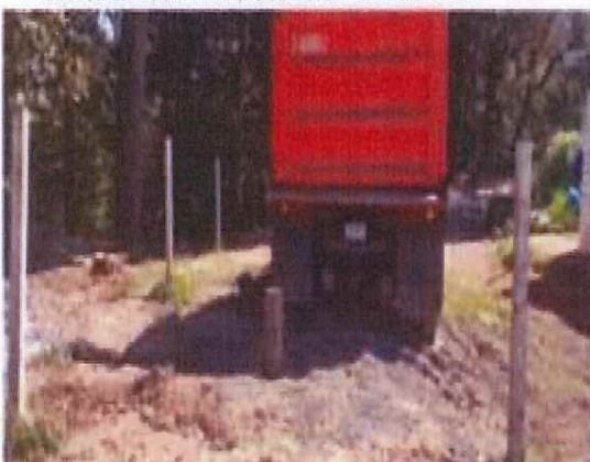
CONSTRUCCION SISTEMA DE AGUA POTABLE CANTON CHUISUC TOTONICAPAN, TOTONICAPAN. (50.00% AVANCE)
